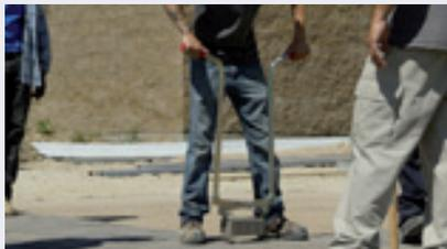
Zum schnellen und bequemen Herausnehmen von Steinen aus nicht verdichteten Belägen, z.B. wenn Markierungssteine eingelegt werden sollen. So werden Einzelsteine aus nicht verdichteten Pflasterbelägen ganz einfach ausgehoben.
