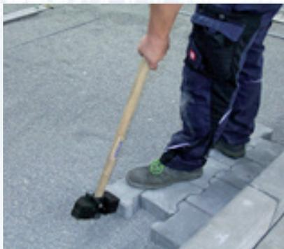
Der Gummihammer wird zum Ausrichten der noch nicht abgerüttelten Verbundsteine verwendet und ist mit zwei unterschiedlichen Gummielementen ausgestattet.
