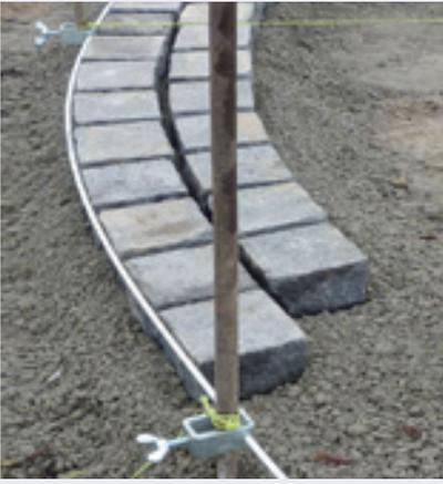
Schwungvolle Wege schnell und ohne optische Brüche erstellen! Komplettsystem zur Gestaltung und Kennzeichnung von frei wählbaren Kurvenverläufen.
